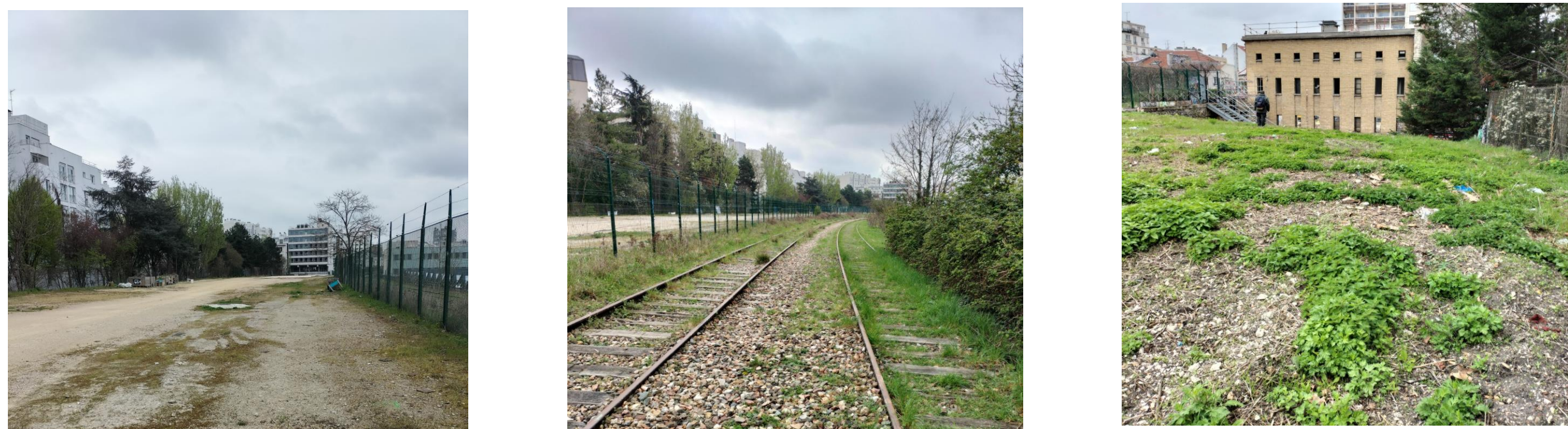
Photos de l'ancienne friche ferroviaire (avril 2023)
